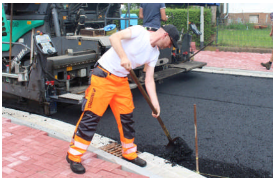
Schweißtreibender Einsatz im Straßenbau.
