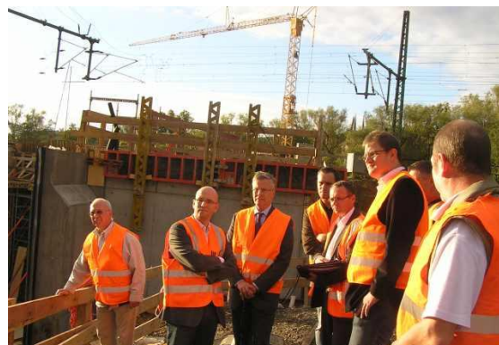
Auf der Baustelle des Bahnübergangs: Peter Tauber.
